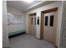
エレベーター(2基)
